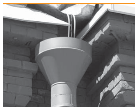
7 водосточные трубы и воронки
