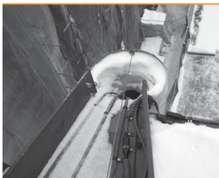
1 водометы и водометные окна в парапетах
